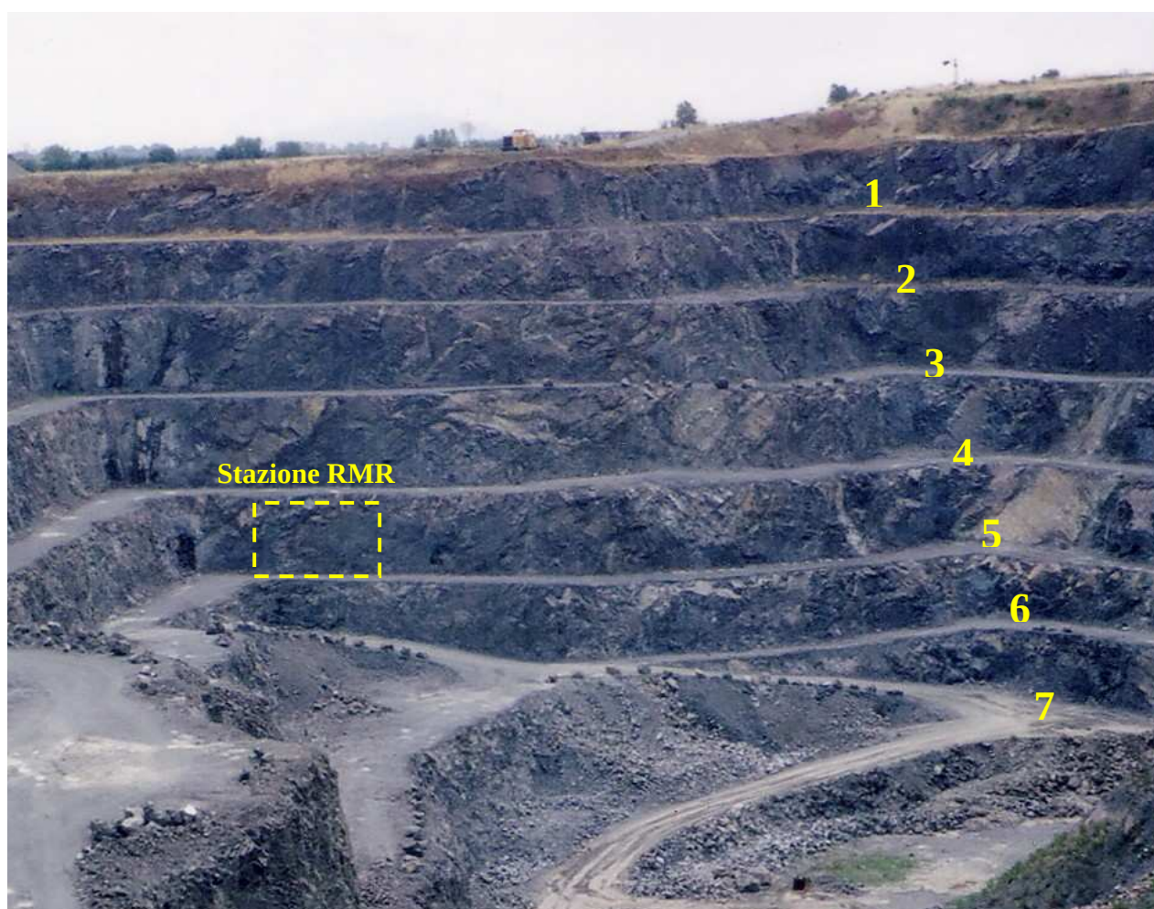
Figura 7 – Fronte sud; i gradoni 1 (quota +20) e 3 (quota + 0) interessati dal rilievo strutturale e il gradone 5 (quota - 20) dal rilievo geomeccanico
