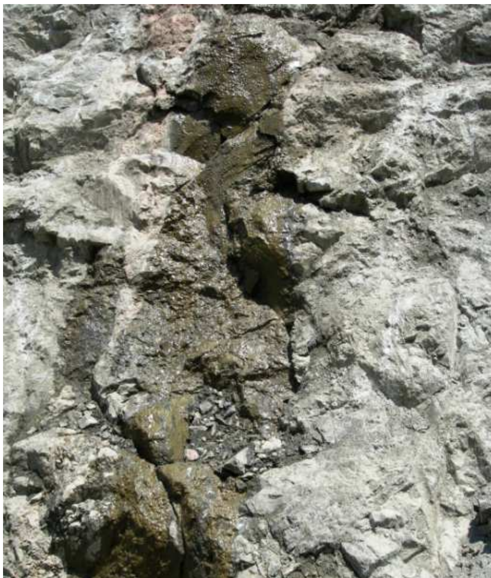
Figura 1 - Filtrazioni idriche nella zona est della cava
